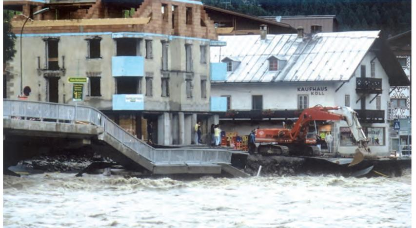
Am Sägewerk der Familie Falkner hat die hochwasserführende Ache die Ufermauer beschädigt und überflutet. Sie ist dann, viel Schotter führend, durch den gesamten Siedlungsraum bis nach Rechenau durch die Häuser geflossen. Sämtliche Keller waren überflutet und im Parterre des Gemeindehauses ist der Schlamm beispielsweise bis zu 80 Zentimeter hoch gestanden. Das Bild zeigt Aufräumarbeiten beim ehemaligen Lebensmittelgeschäft Neururer.
