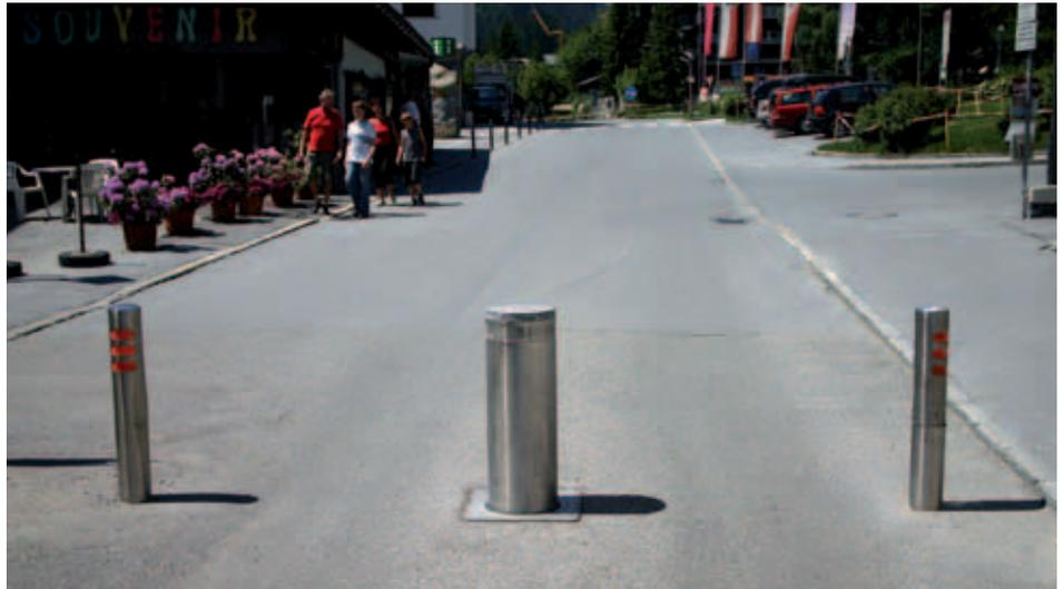
Mit Funksteuerung versenkbare Poller an den Eingängen zur Fußgängerzone.
