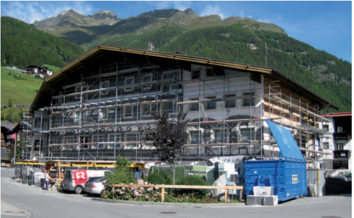
*Im Gemeindehaus ist seit Mai ein Um- und Erweiterungsbau der Amträume im Gange. Zudem wird der Haupteingangsbereich verlegt, die Fassade des 30 Jahre alten Gebäudes wird mit einer zeitgemäßen Wärmedämmung aufgerüstet und die Fenster werden ausgetauscht. Ebenso wird das Dach erneuert und wärmegeämmt.*
